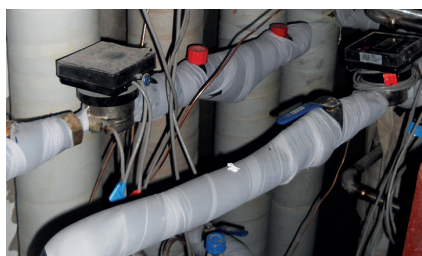
Des vannes d'équilibrage Danfoss ASV et des compteurs d'énergie ont été prévus dans la salle technique par groupe de quatre appartements.
